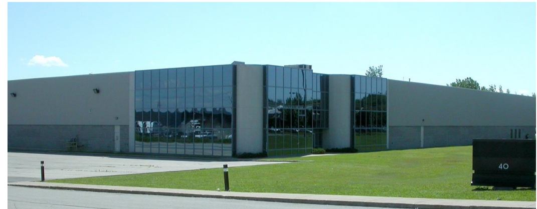
40 chemin du Tremblay – Boucherville 143 000 pi 2
